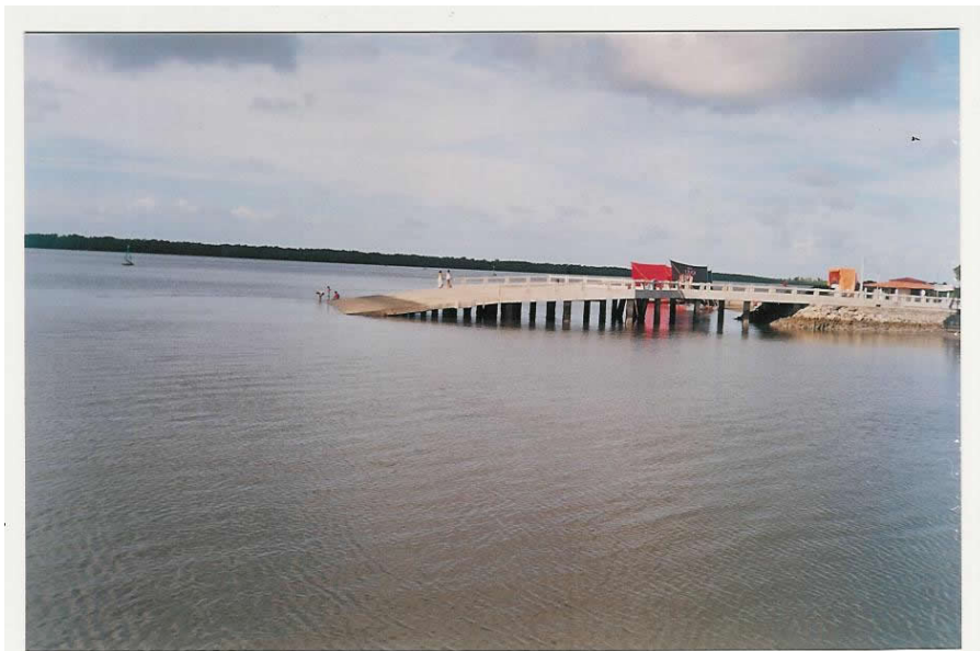
Figura 5: Atracadouro da balsa – Terra Caída
