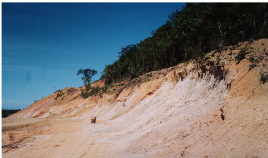
Figura 4: Taludes com escorregamentos. Acima, mata (invasão de APP)
